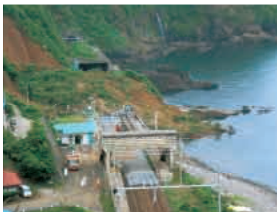
土砂に埋もれた線路（新潟県中越沖地震）
