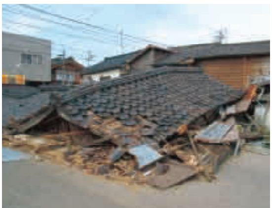
倒壊する家屋（新潟県中越沖地震）
