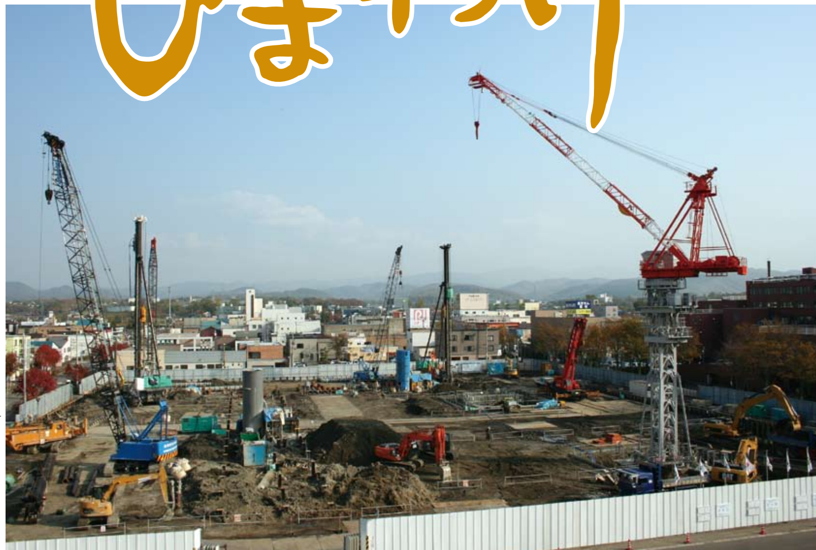
【新病院工事の様子】
