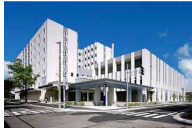
新本館 平成22年10月開院
