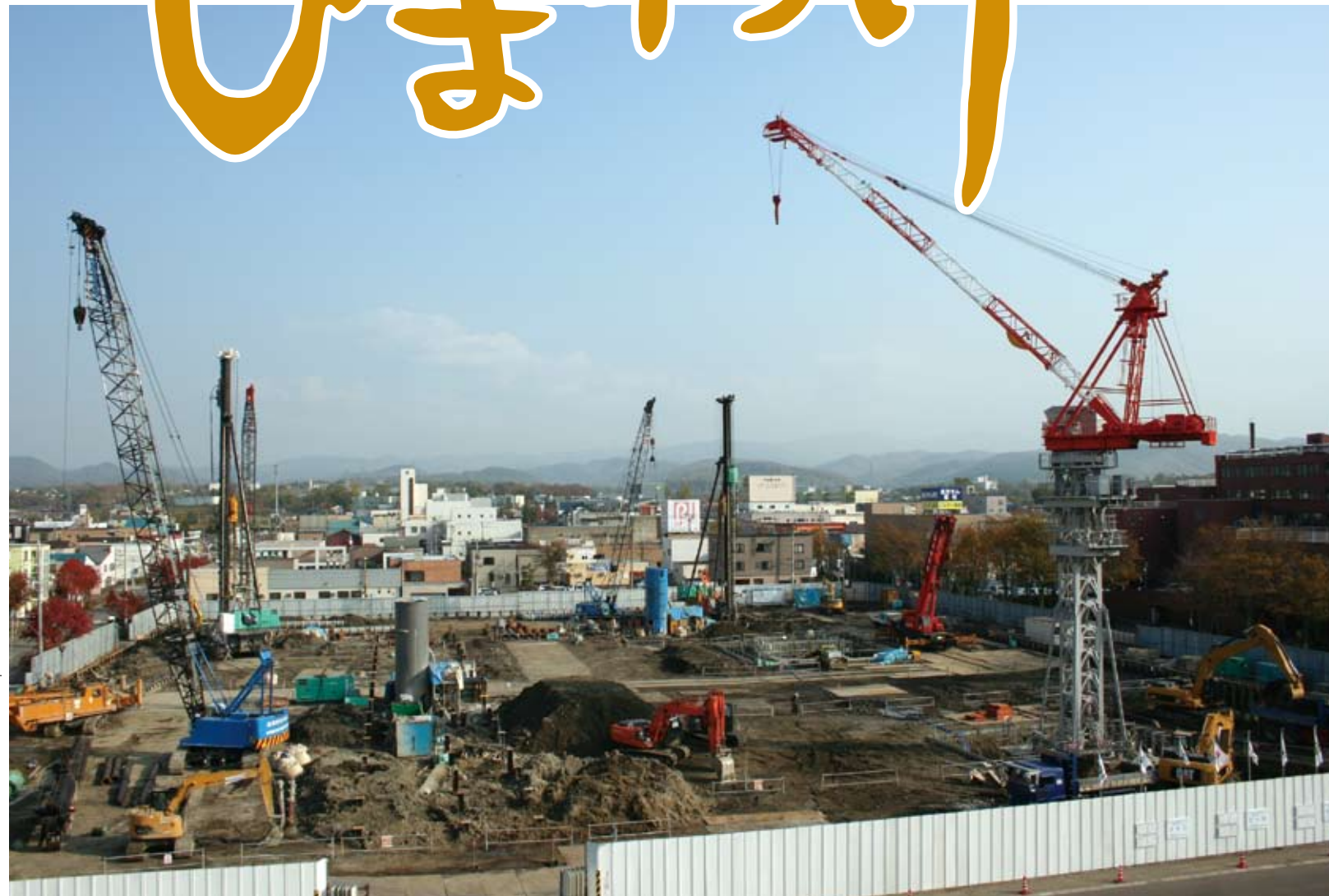
【新病院工事の様子】
