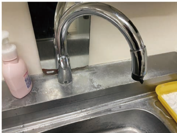
図 14：タッチレス水栓取替工事を実施
